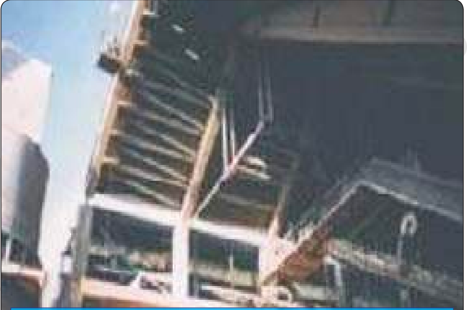
HAMMADDE STOKHOLÜ DOLDURMA BANDI TAŞIYICI ASKILI ÇELİK PLATFORM MONTAJI
