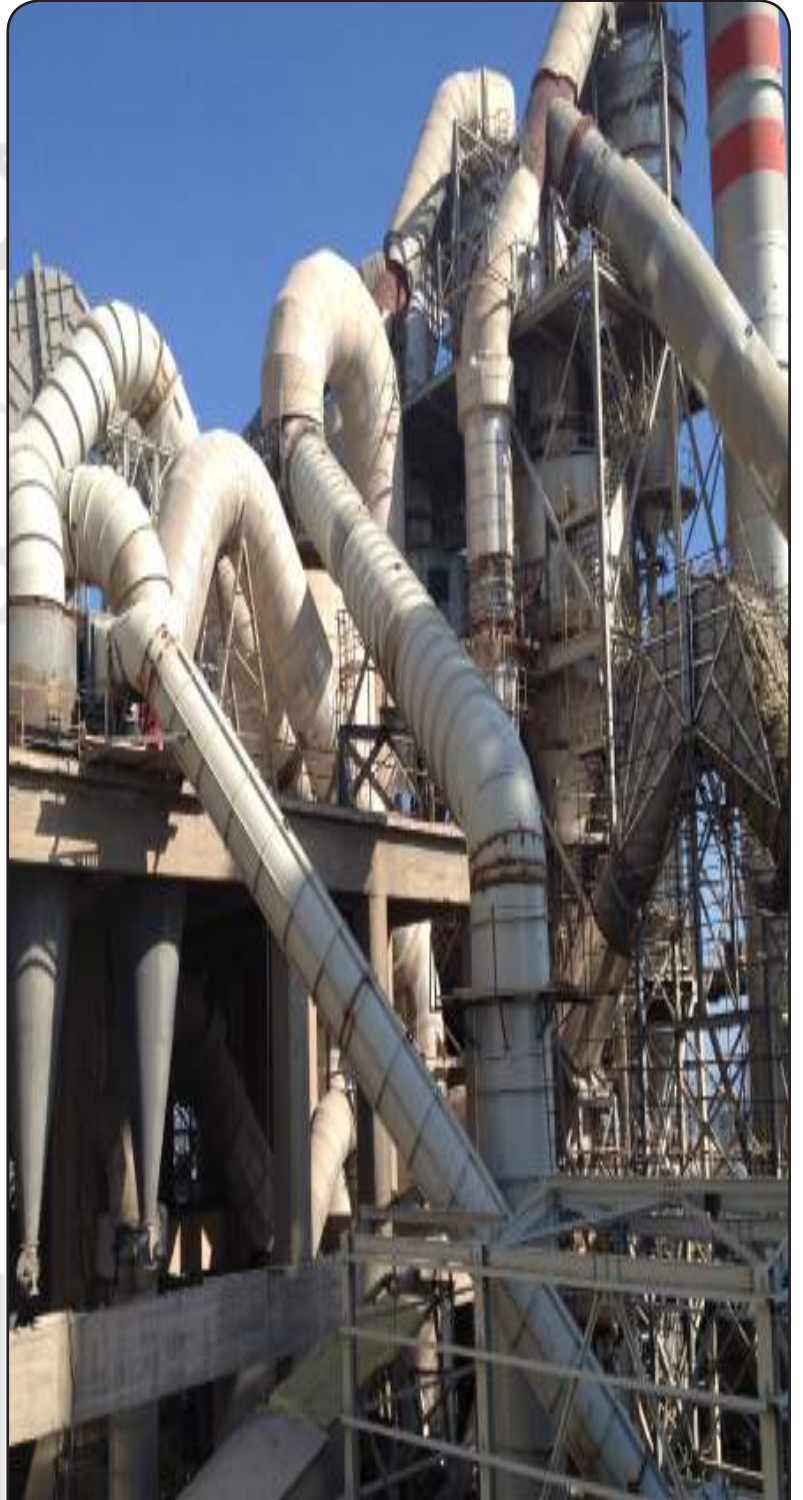
FLUSH KURUTUCU ÜNİTESİ MONTAJI
