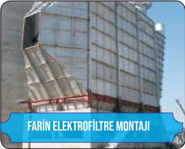
FARİN ELEKTROFİLTRE MONTAJI
