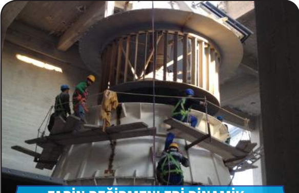
FARİN DEĞİRMENLERİ DİNAMİK SEPERATÖR İMALAT VE MONTAJLARI
