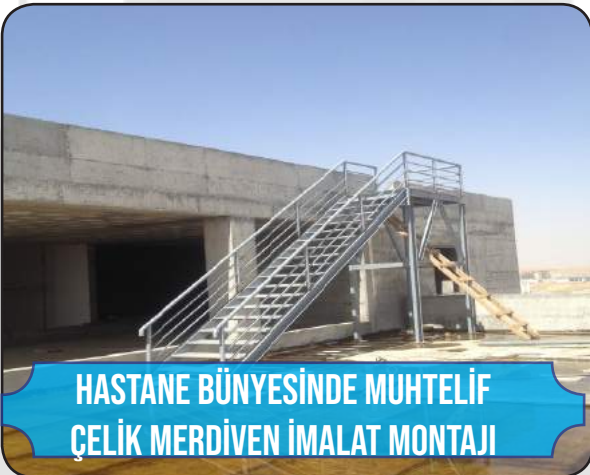
HASTANE BİNALARI ARASI ÇELİK KONSTRÜKSİYON İMALAT MONTAJI
