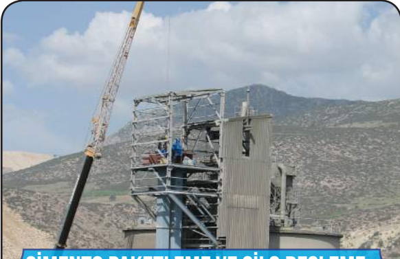
ÇİMENTO PAKETLEME VE SİLO BESLEME ELEVATÖRÜ MONTAJI
