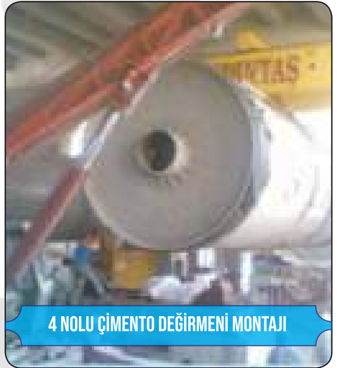
ÇİMENTO DEĞİRMENİ DİYAFRAM VE PLAKA MONTAJI ÜZERİNE MONTAJI
