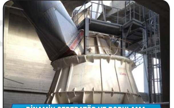
DİNAMİK SEPERATÖR VE BORULAMA İMALAT MONTAJLARI
